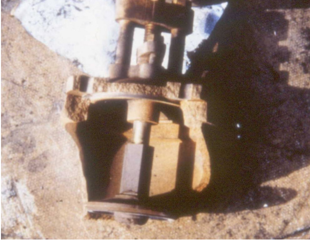
Rysunek 2: Zawór zniszczony przez uderzenie wodne
